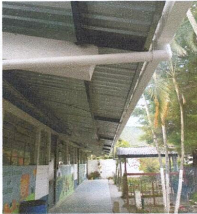
Foto 3: Trabajo de Canales y bajadas pluviales
